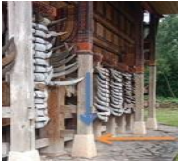
Gambar 3. Prinsip pada tiang lentong garopang Gaya berat (F)
